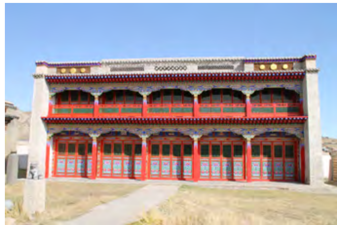
Fig. 3 : bâtiment est restauré du Monastère – musée Zayain Khuree, ville de Tsetserleg, photo J. Magail, 2011
