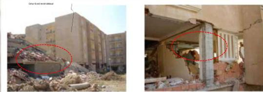
On observe deux cas de figure, la disparition totale du rez-de-chaussée d'un bâtiment résidentiel privé en R+1 et le deuxième cas disparition total d'un bâtiment collectif en R+4 (Source : rapport (Japan Association of Earthquake Engineering (JAEE) et al., 2004).
